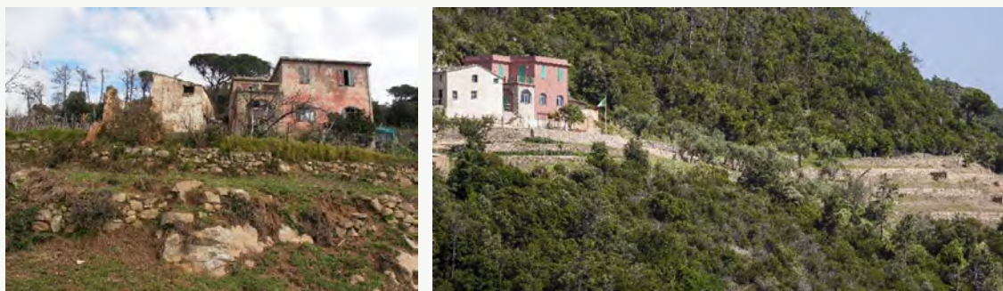
Figure 1-2 - Viste di Casa Lovara, prima (sinistra) e dopo (destra) gli interventi di restauro e valorizzazione
