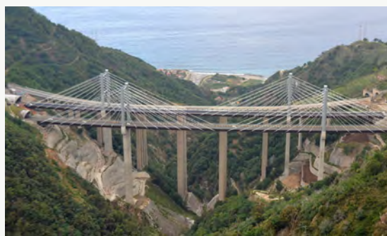
Figura 1 – Il nuovo viadotto Favazzina, in primo piano, adiacente al vecchio viadotto, in secondo piano, oggi demolito
