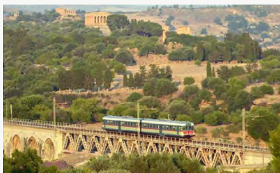
Figura 1 – La ferrovia dei Templi, recuperata nell'ambito del progetto
