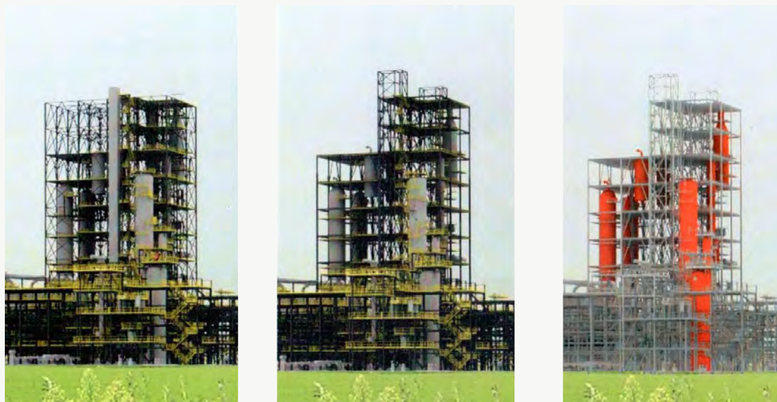
Figura 1 – Fasi progettuali per la realizzazione del nuovo impianto: 1. Progetto originario (a sinistra); 2. Alleggerimento strutturale (al centro); 3. Mitigazione e valorizzazione cromatica (a destra)
