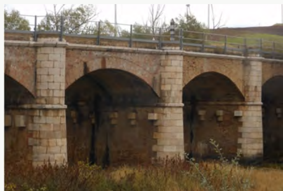
Figura 3 – Viadotto lungo la linea ferroviaria Foggia-Potenza
