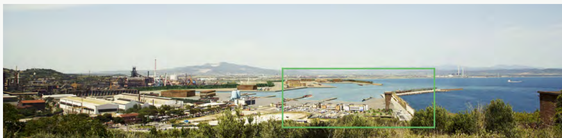
Figura 1 - Vista complessiva del porto (nel rettangolo verde l'area oggetto di intervento)
