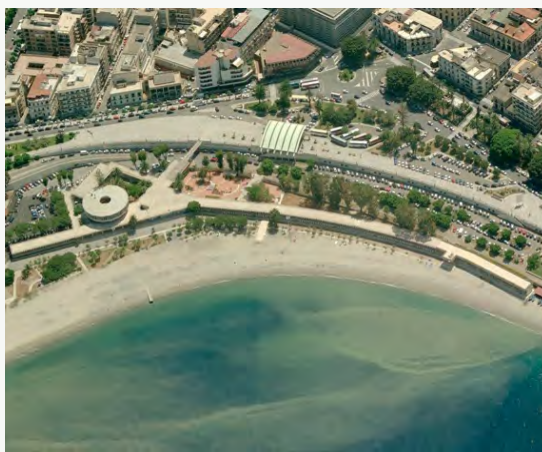
Figura 2 - Foto aerea del complesso architettonico del Lido Comunale e del Lungomare Falcomatà
