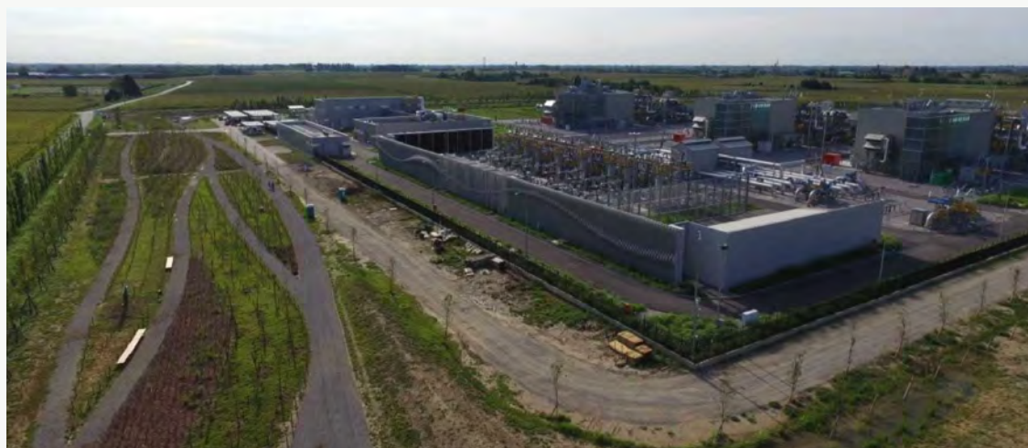
Figura 1 - La centrale di Bordolano
