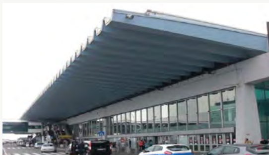
Figura 2 – Facciata del Terminal (ante operam)
